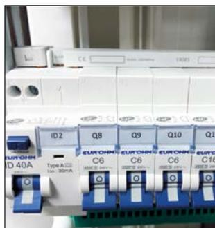
Dégagement de la partie supérieure des accessoires modulaires pour le passage des dents de peigne horizontal (contacteur, contacteur J/N, sonnette, télérupteur, prises modulaires, voyant modulaire). Pour positionner ces accessoires librement entre les disjoncteurs et pas en fin de rangée.
